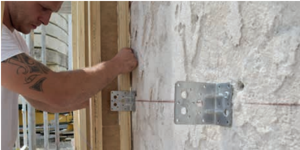
Befestigen der Stegträger STEICOjoist auf verputzter Bestandswand
