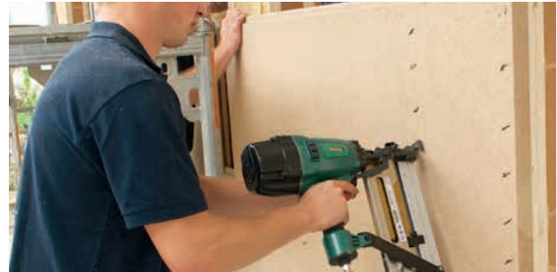
Schließen der Gefache mit der Holzfaser-Dämmplatte STEICOprotect H
