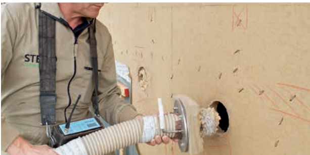
Füllen der Gefache mit der Holzfaser-Einblasdämmung STEICOzell
