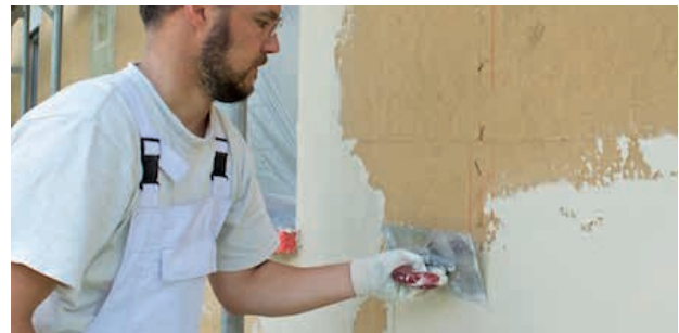
Auftragen des Putzsystems STEICOsecure auf die STEICOprotect H
