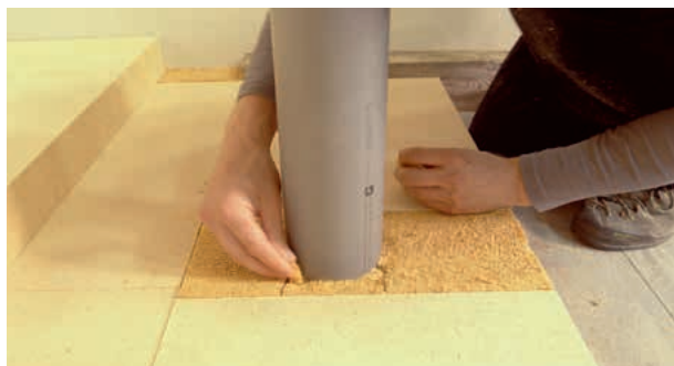
...und dann mit kleinen Stücken der STEICO flex 036 lückenlos gefüllt.
