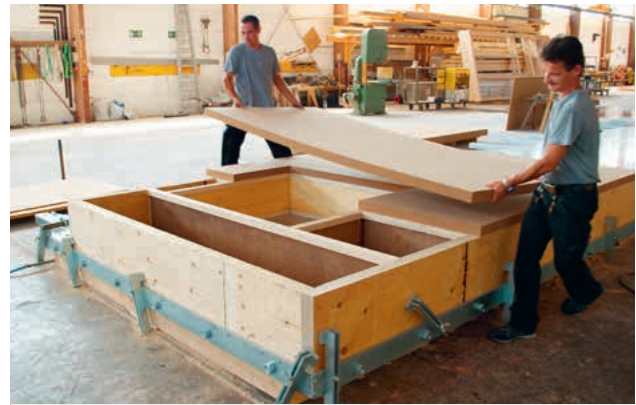
Beplankung mit STEICOprotect H. Aussteifung während der Bauphase und Witterungsschutz
