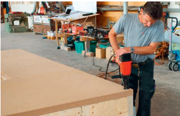
Befestigung von STEICOprotect H mit Edelstahl-Breitrückenklemmen
