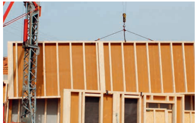
Montagefertiges Wandelement am Kranhaken, für Montage bereit
