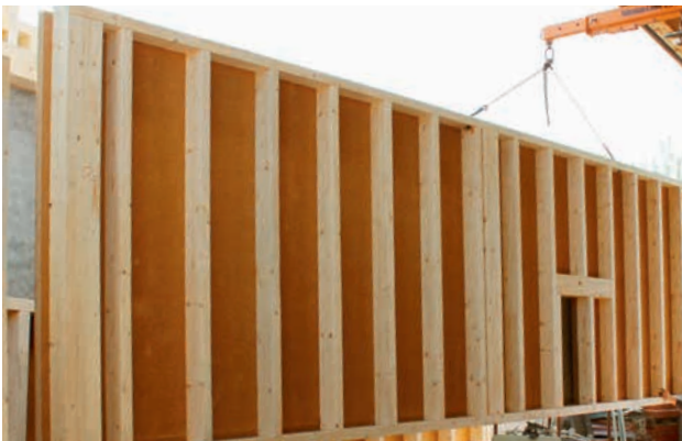
Einseitig beplantes Wandelement bei der Verladung, ausgesteift durch die STEICOprotect H
