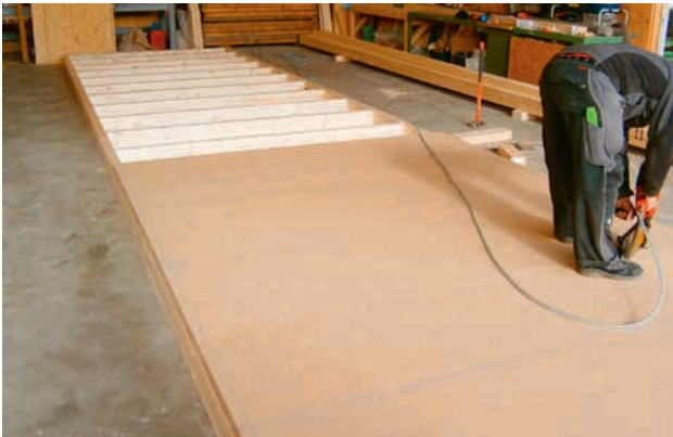
Bepunktung einer Erdgeschosswand mit der aussteifenden STEICOprotect H
