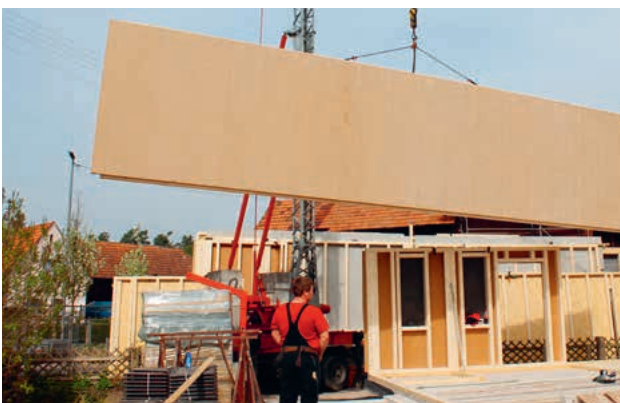
Außenansicht; vor Witterung geschützte, diffusionsoffene Wandtafel
