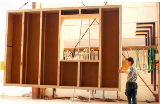
Fertiges Element am Kran; wirtschaftliche und schnelle Fertigung mit geringem Personaleinsatz
