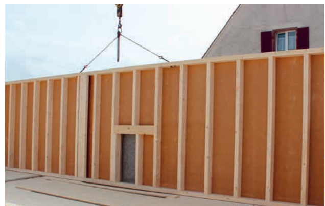
Erste Wand des Ausbauhauses bei der Baustellenmontage
