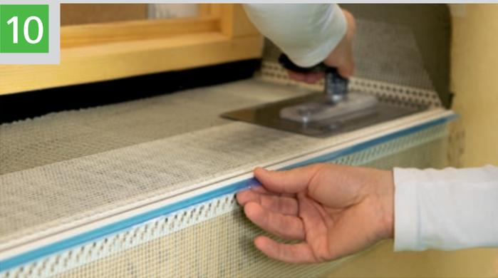
Einbau: Gewebeeckwinkel seitlich (optional), Gewebeeinlage flächig, STEICOsecure Abschlussprofil FB an Vorderkante
