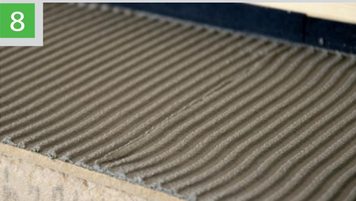
Das Abzählen in Gefällrichtung erfolgt mit einer Zahntraufel 6,0 mm zur Erzielung der Trockenschichtdicke von mind. 4,0 bis max. 10,0 mm
