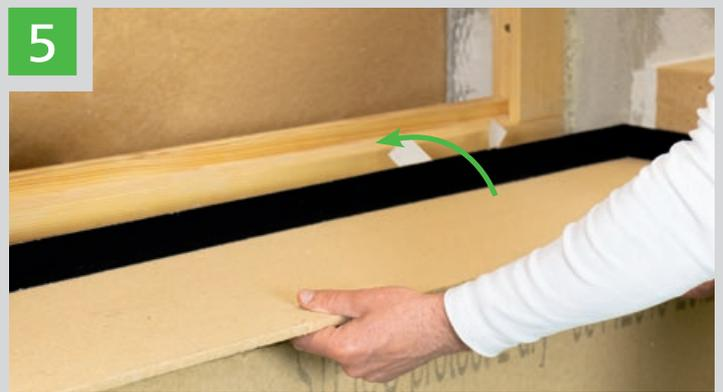
Einbau **STEICOtri** Dämmkeil: Unter Druck satt in den Kleber einschwimmen
