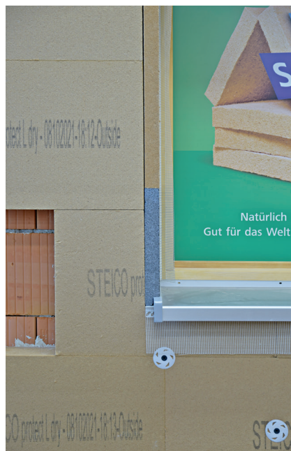
3 Die Fensterlaibung ist mit einer 4 cm starken Laibungsplatte gedämmt, über der Fensterbank mit der systemintegrierten Spritzschutzplatte. Fotos: SteicoSE
