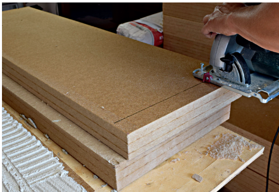
4b Zuschneiden der Dämmplatten: Für die Längen- und Breitenzuschnitte sind Kreissägeblätter mit grober Zahnteilung ideal, für die Detailarbeiten Stichsagen.
