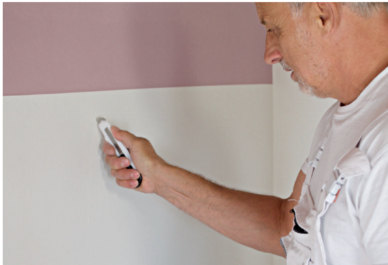
4a Vorbereitung des Untergrunds: Haftmindernde, diffusionshemmende oder kapillar undurchlässige Schichten sind zu entfernen, evt. Unebenheiten auszugleichen.
