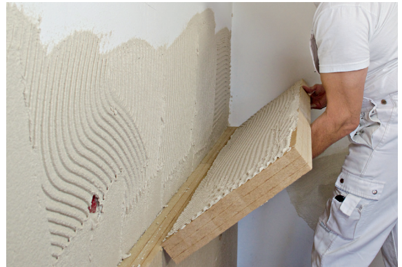
4d Kräftiges „Einschieben“ sorgt für eine vollflächige Haftung der Dämmplatten. Diese werden im Verband verlegt, wobei der Stoßfugenversatz mindestens 20 cm betragen sollte.
