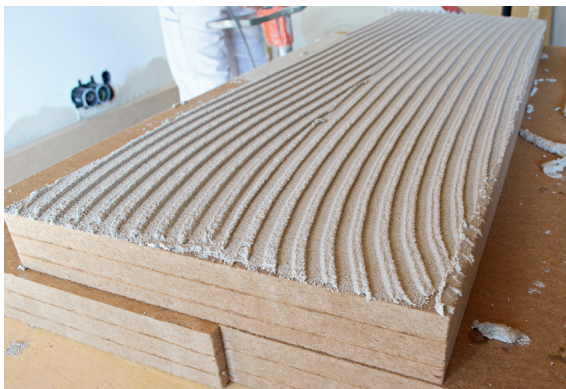
4c Befestigen der Dämmplatten: Mit einer Zahnpachtel 10 mm wird der Klebemörtel auf die Wandoberfläche und auf die glattere Seite der Dämmplatte aufgebracht.
