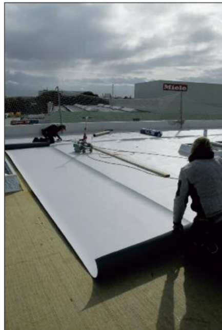
Altes Industriedach mit der schwarzen Sanierungsbahn WOLFIN GWSK saniert.
