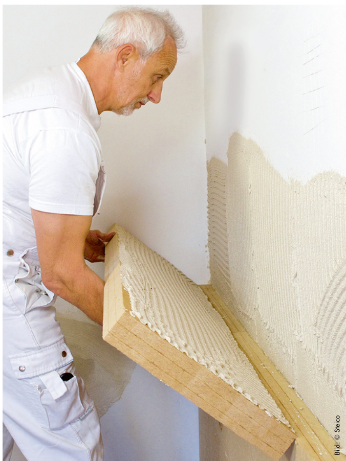
4 | Schlank, einfach und schnell umsetzbar: Eine robuste Holzfaser-Dämmplatte wird vollflächig auf die Bestandswand geklebt und dann innen verputzt. Diese Lösung ist diffusionsoffen und feuchteregulierend.
