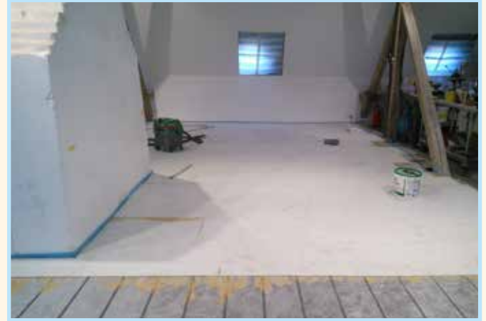
Entkopplungsplatte auf PowerFloor Slimline
